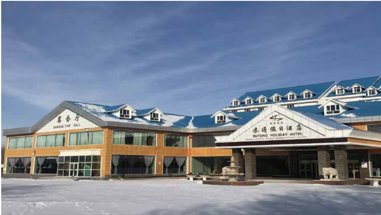
项目名称： 新疆阿勒泰苏通假日酒店供暖项目 项目简介： 该地冬季极寒气温可到-35℃，酒店供暖面积约40,000m²，采用14台60HP海悟商用空气能热泵采暖机，海悟热泵冷暖兼供，全年运行费用比改造前节省24%，已稳定运行2个采暖季。
