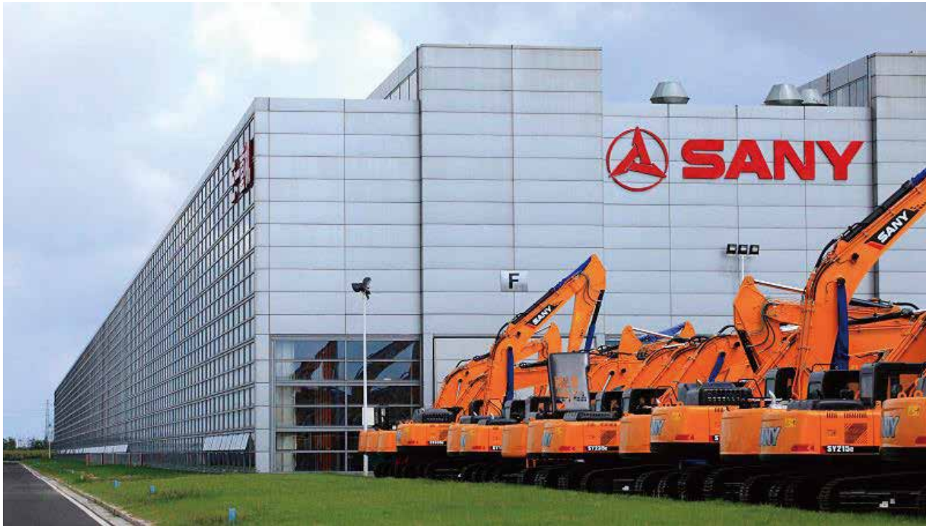
项目名称： 新疆三一重工办公楼供暖项目 项目简介： 海悟凭借行业领先的综合方案解决能力，为客户提供从“勘探、方案、产品、安装、售后”一条龙服务，采暖室内平均温度达18℃以上；该项目还配置了海悟自研的云平台，远程云监控，运行/故障状态实时掌握。
