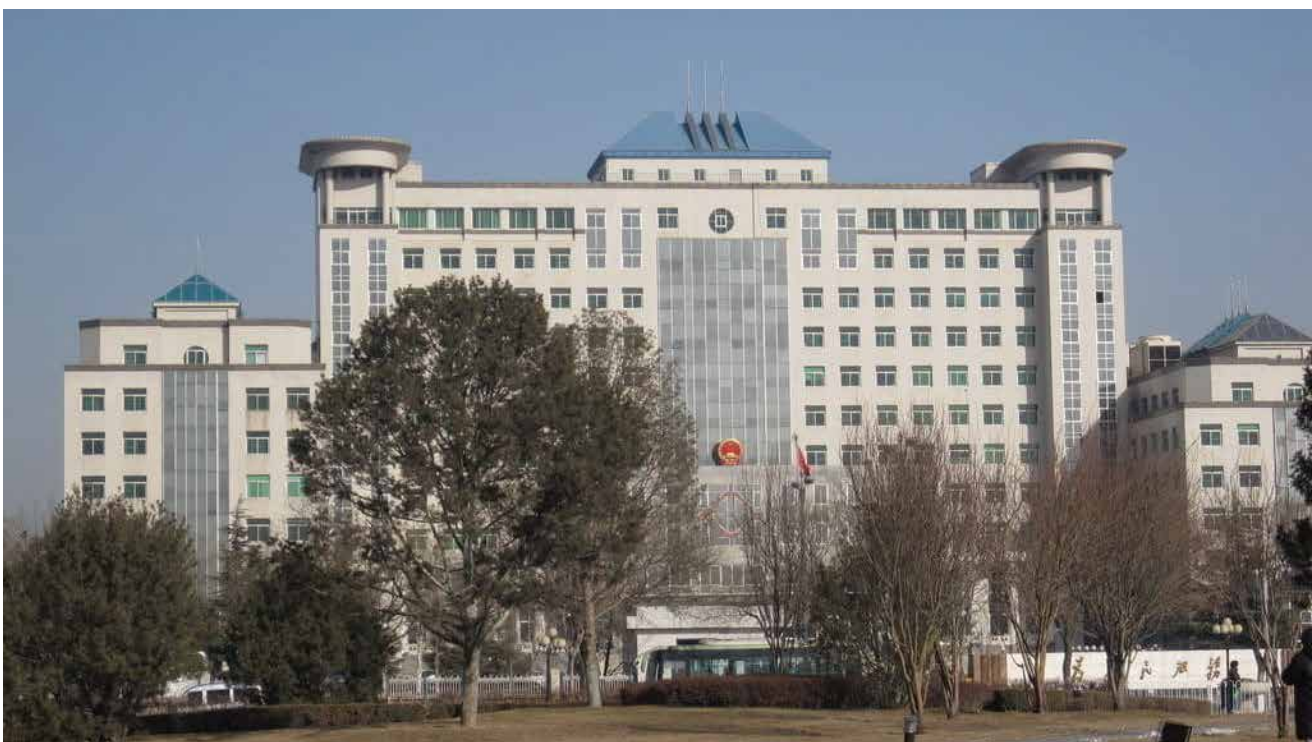
项目名称： 2016年北京市房山区农村“煤改电” 项目简介： 海悟采用3HP、5HP、6HP直流变频采暖机组，采暖迅速，高效节能，是“煤改电”系列项目中，首批采用变频技术的企业。
