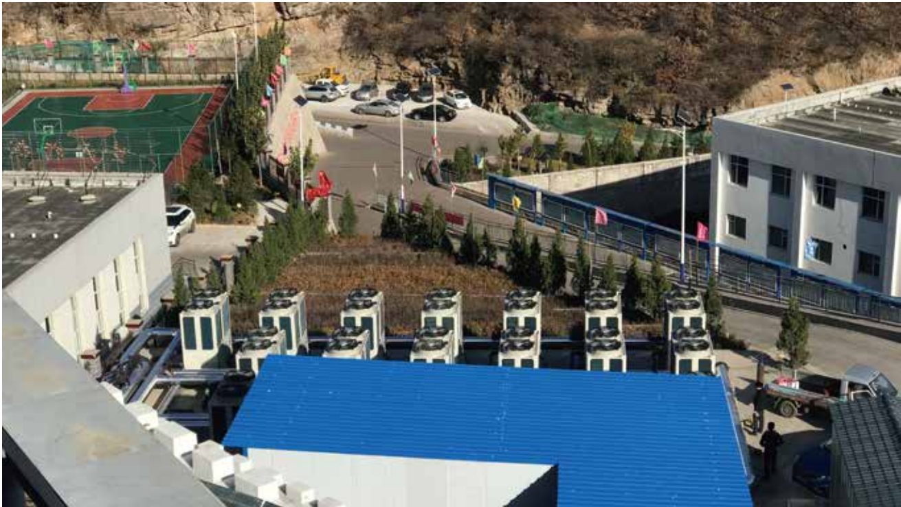
项目名称： 山西省大同市同煤集团四老沟矿热水项目 项目简介： 四老沟矿位于大同市西南25公里处，井田面积29.83平方公里，日用水量可达680吨。海悟通过综合设计选型，匹配了12台型号为HLLS105P2C7A超低温型热水机组，因为煤矿的特殊性，海悟增加了防腐设计，安全可靠运行得到保障。
