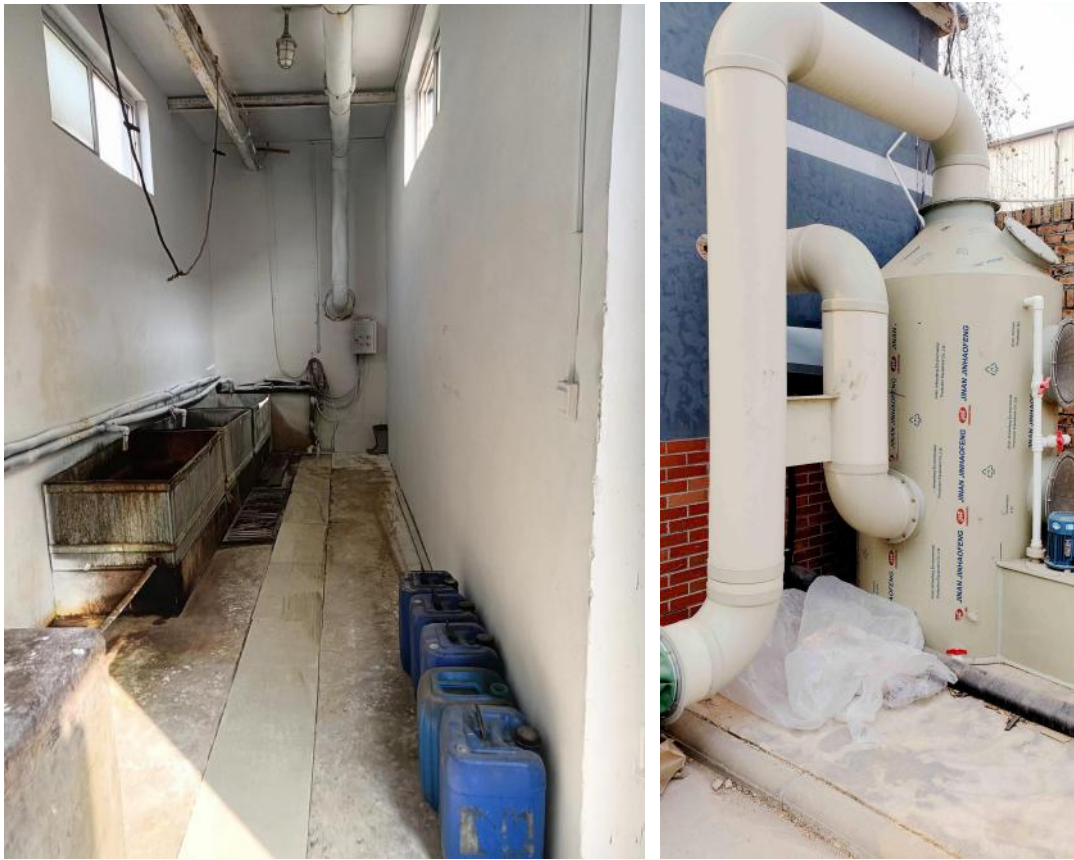
图 4-1 酸洗房废气收集管路和喷淋塔
