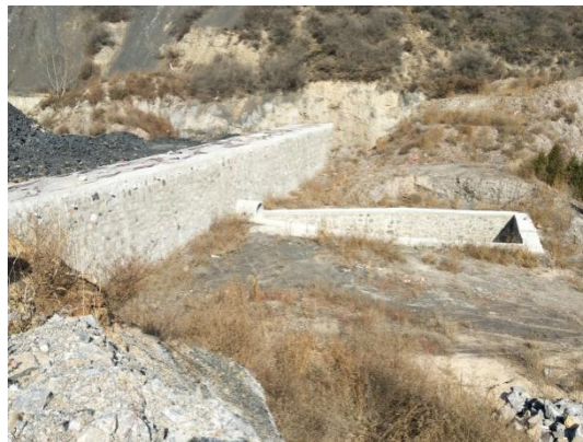
新矸石场拦矸坝、排水涵洞、消力池
