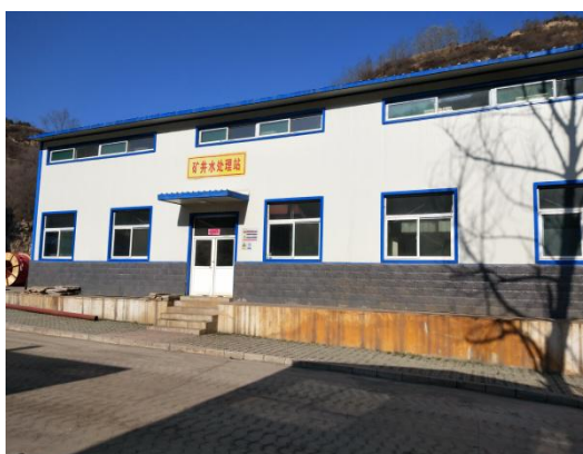
矿井水处理站
