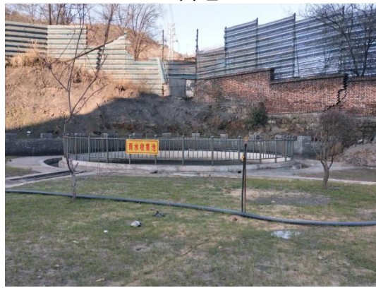
初期雨水收集池
