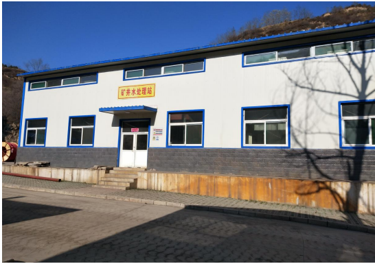
矿井水处理站
