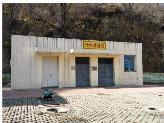
生活污水处理站
