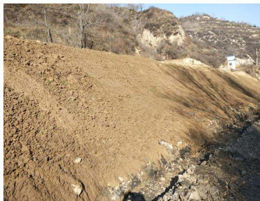
副斜井南沟道原有矸石场
