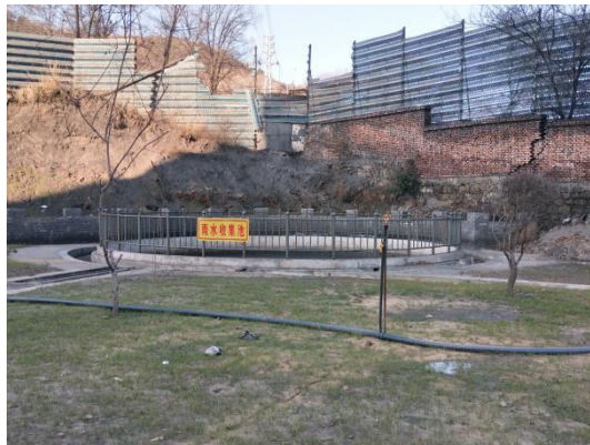
初期雨水收集池
