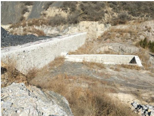
拦矸坝、排水涵洞、消力池
