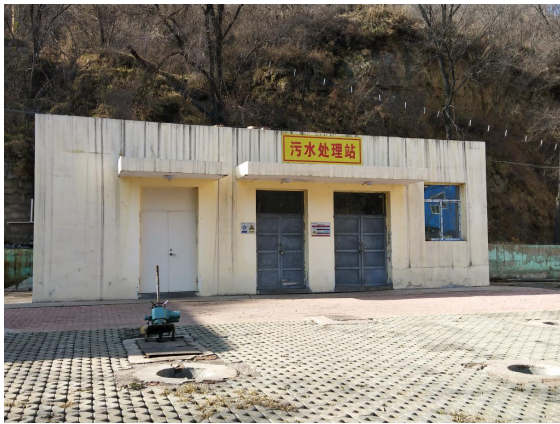
生活污水处理站
