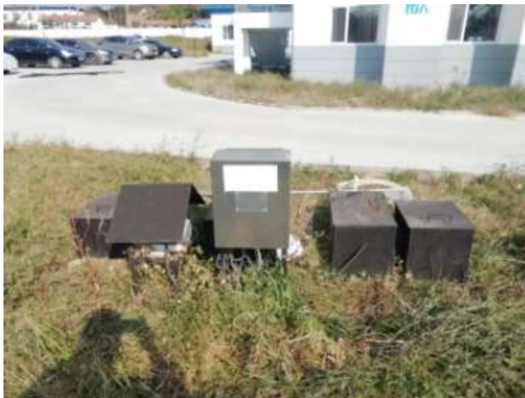
图 7.1 埋地式一体化污水处理系统
